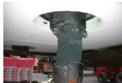
Abb. 243: nach Brandversuch - Gussleitung verschlossen
