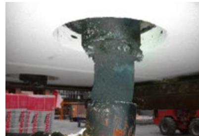
Abb. 243: nach Brandversuch - Gussleitung verschlossen
