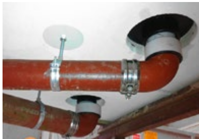
Abb. 242: Guss/HT-Verbinder/Advantix-Brandschutzablauf
