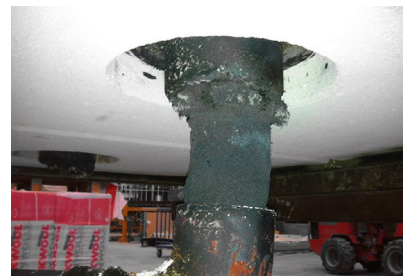
Abb. 243: nach Brandversuch - Gussleitung verschlossen
