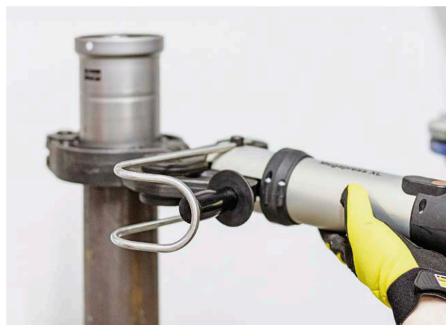
Die termintreue Umsetzung aller Installationen gelang auch dank der alle Rohrsysteme umfassenden Pressverbindungstechnik, hier mit dem Pressgun-Press Booster an einem Megapress S XL-Verbinder.
