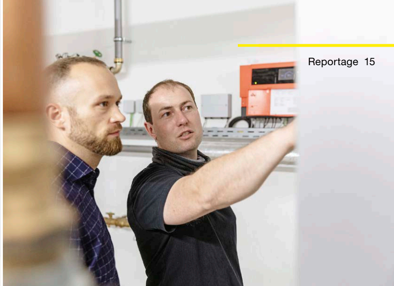
Für SHK-Meister Marcus Schietzold (re.), hier mit Viega Verkaufsberater Markus Decker, war der Viega Systemverbund für die Rohrleitungsinstallationen im Kotsch-Neubau von Anfang an gesetzt.
